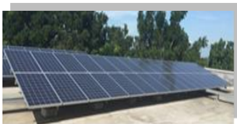
รูปที่ 2. แผงโซลาร์โซลาร์เซลล์ ชนิด โพลีคริสตัลไลน์ซิลิคอน Polycrystalline Silicon
