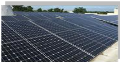
รูปที่ 1. แผงโซลาร์เซลล์ ชนิด โมโนคริสตัลไลน์ (Monocrystalline Silicon)
